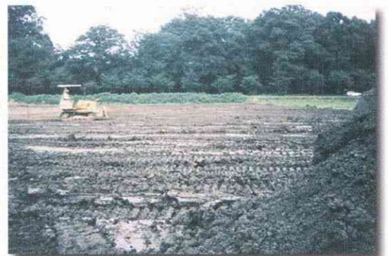
脱水ケーキ再成土盛土利用現場
