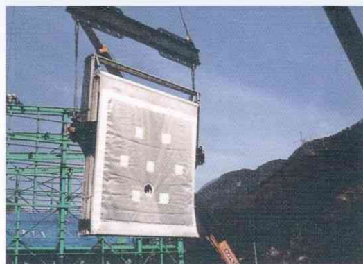
▲2000型フィルタープレス汚板組立状況
